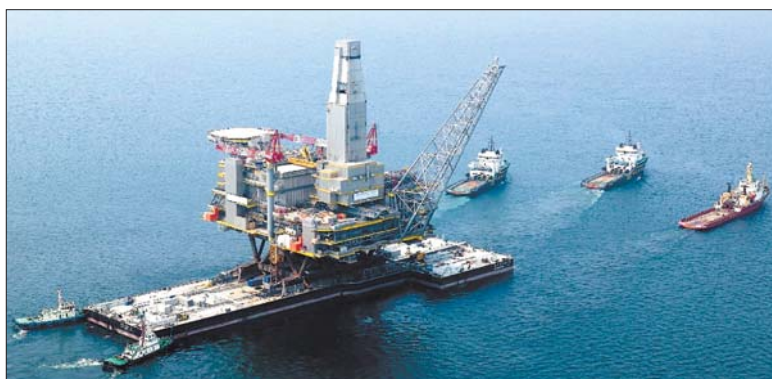
Буксировка буровой платформы к месту установки
